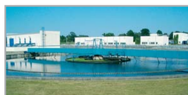
Очистное сооружение сточных вод
